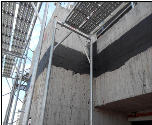
1.外牆樓層接縫處理
