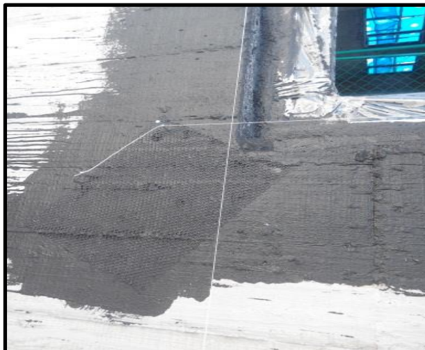
2.外牆窗框四週防水處理1
