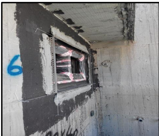
3.外牆窗框四週防水處理2
